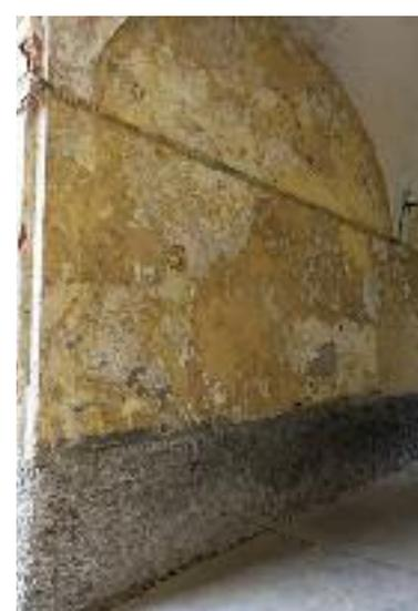
Vi sono infiltrazioni d’acqua dalle coperture ed evidenze di umidità di risalita con fenomeni di distacchi, esfoliazione e disgregamento degli intonaci; tuttavia non sono da escludere problemi più gravi della struttura che potrebbe essere stata compromessa anch’essa dall’acqua.
